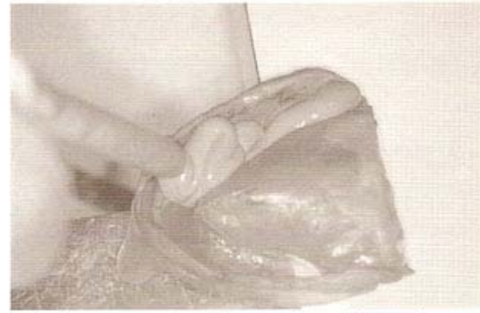
Figura 20. Inicio de la aplicación de la silicona de mayor escurrimiento.
